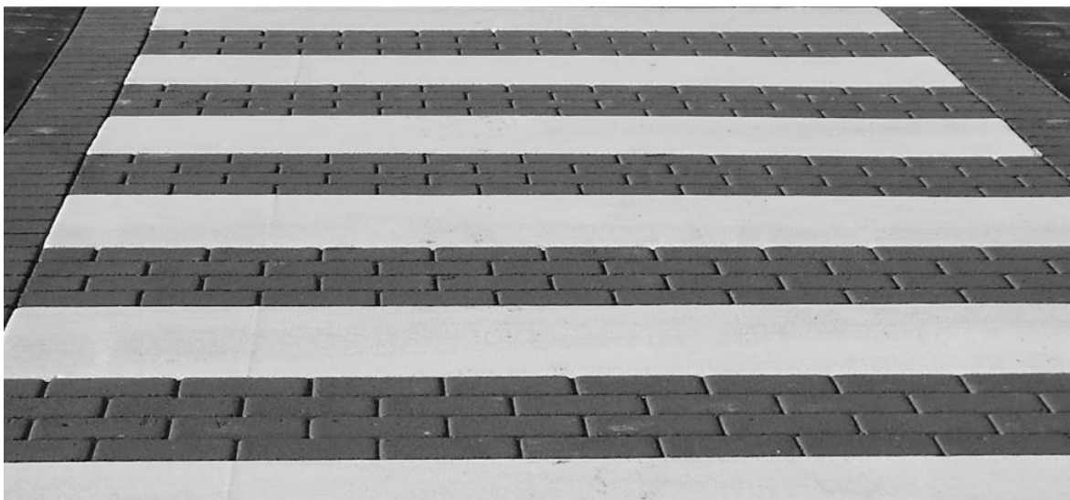
Figura 5 - esempio intervento con asfalto stampato
