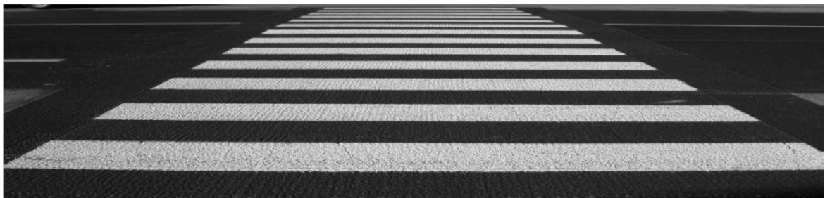
Figura 4 - esempio intervento con colato plastico
