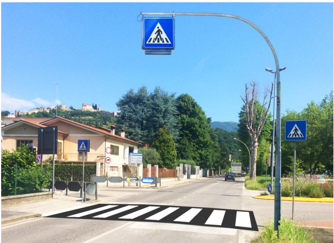
Figura 6 - esempio intervento illuminazione
