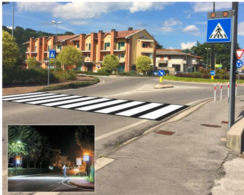
Figura 7 - esempio intervento illuminazione 2
