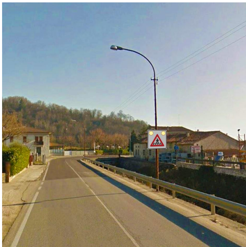
Figura 8 - esempio intervento illuminazione 3
